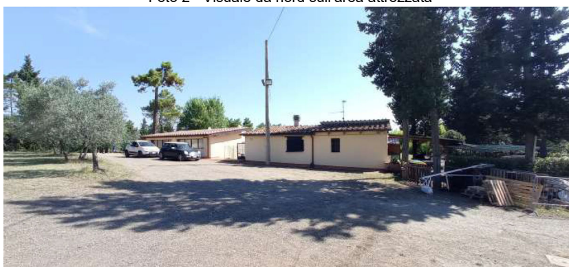
Foto 3 - Visuale da sud, sugli edifici esistenti
